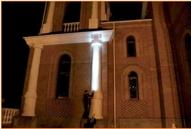
Фото 2. Подсветка колонны здания при помощи светодиодного прожектора
