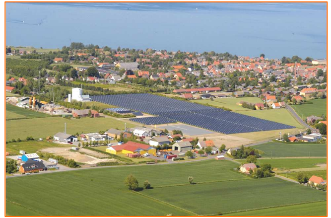
Рис. 1. Общий вид гелиоустановки тепловой мощностью 12,8 МВт (г. Марсталь, остров Аэро, Дания).
